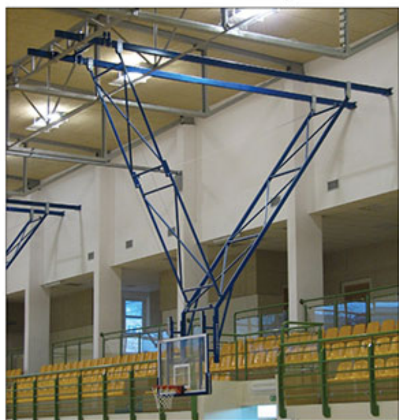
Koštrukcia montovaná mimo nosníkov
