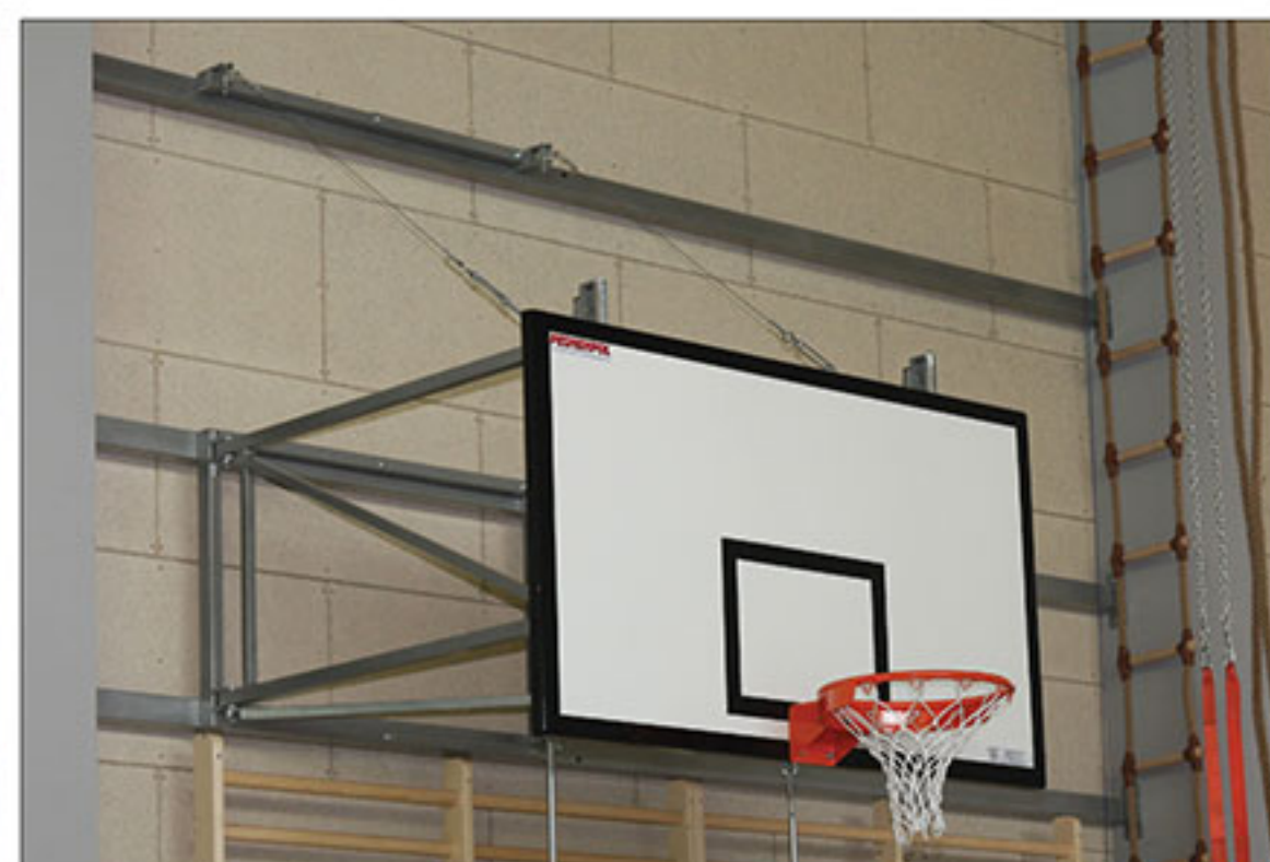
Konštrukcia montovaná medzi železobetónovými stĺpmi
