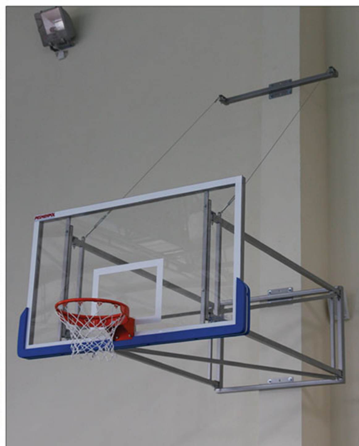
Konštrukcia montovaná do železobetónového stĺpu
