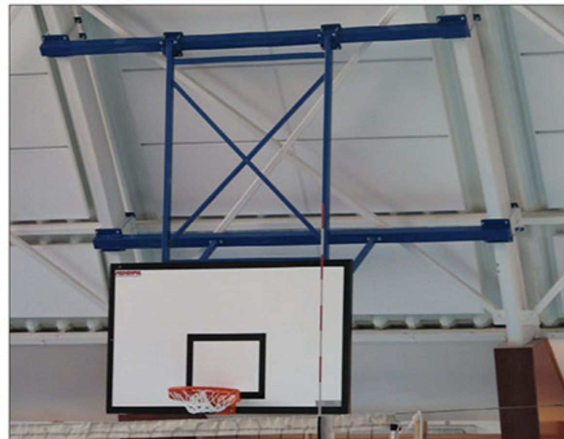
Konštrukcia montovaná na strešnú konštrukciu
