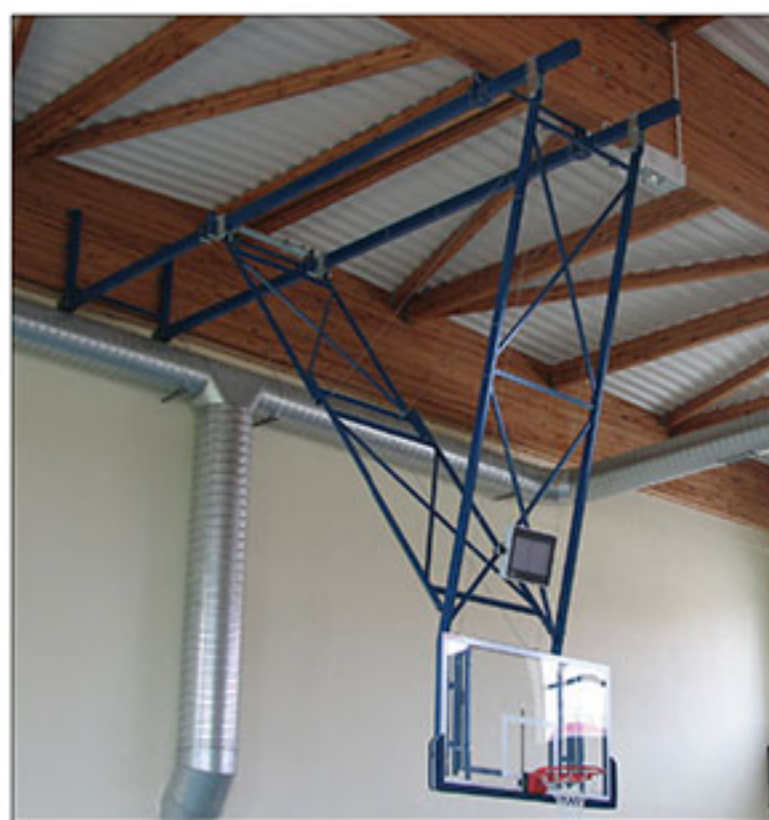
Montáž na drevené nosníky
