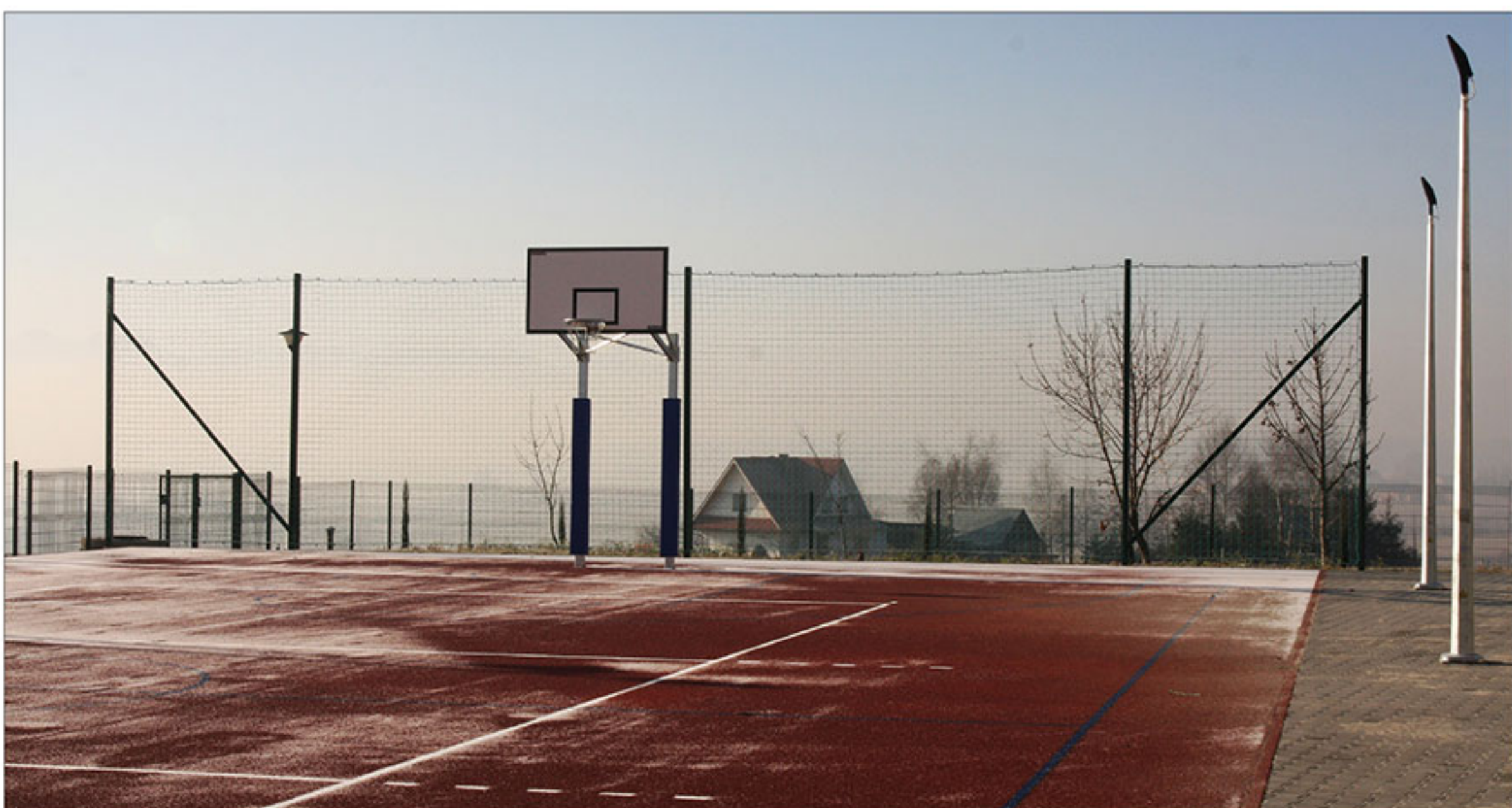
Voľne stojaca konštrukcia s ochrannou sieťou
